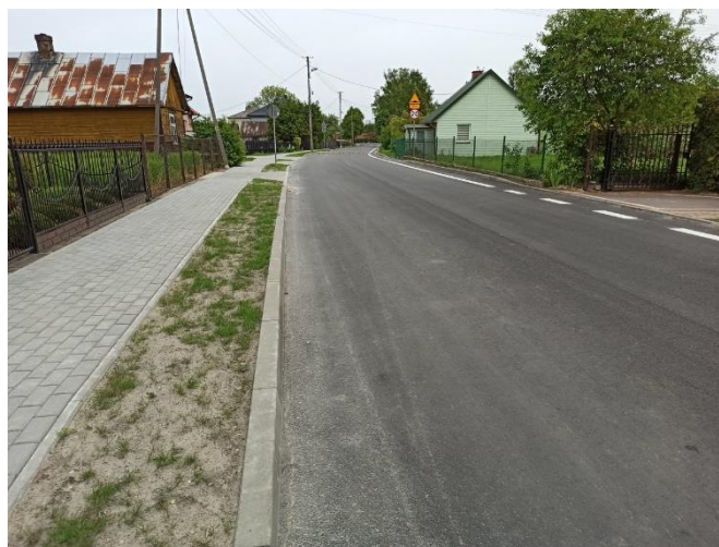
Przebudowane drogi gminne
